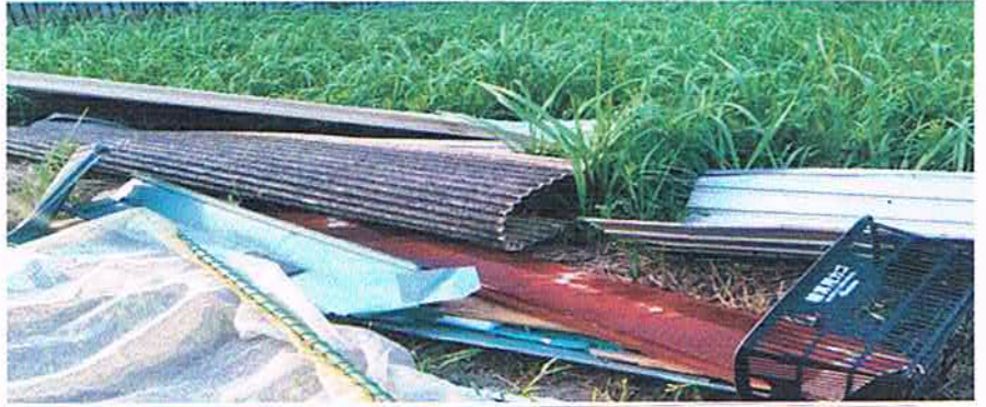
強風で吹き飛ばされた屋根材が目立ちます(当団地内)
