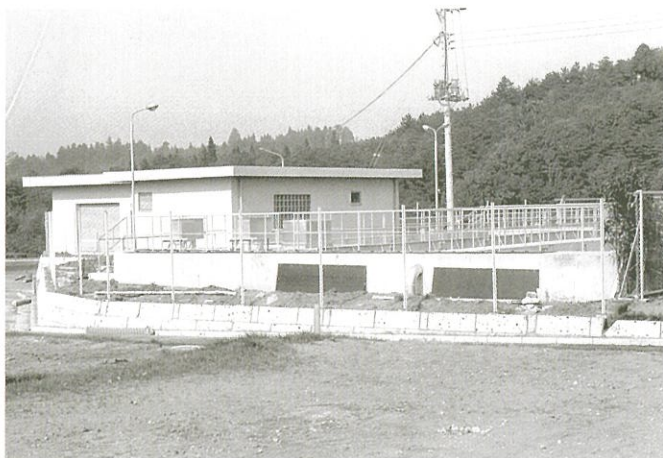
下水処理施設 現在の自治会館敷地（1985：昭和60年）
