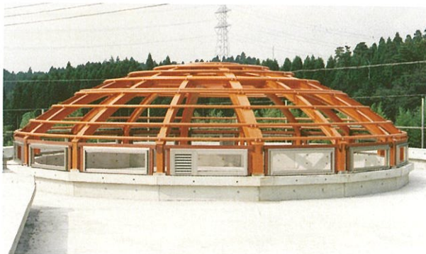
大椎台自治会館建築風景（1993：平成5年）
