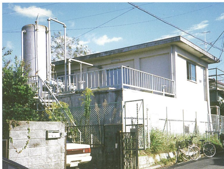
19ブロックにあったポンプ場（1987：昭和62年）
